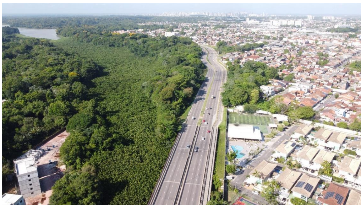
Figura 3. Limite entre o Lago Água Preta e a área urbanizada.
